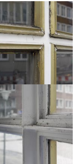
Außen: Farbliche Gliederung und Profilausformung erzeugen ein feines Linienspiel. Innen: Fassadenpfosten- und riegel laufen in einem schlanken Stahlschwert aus. Fotos: jr
