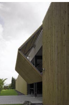
Auch westfälisch? Parkpalette in Coesfeld-Lette, Birk und Heilmeyer, Stuttgart, Deubau-Preis 2010, Foto: Christian Richters
